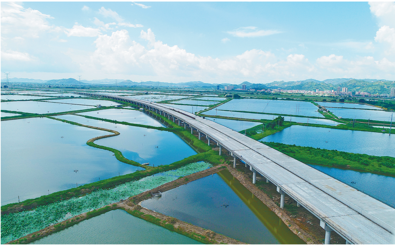
6月21日,由中铁十二局四公司承建的潮(州)汕(头)环线高速公路海田特大桥主体完工。该桥全长3.24公里,是全线唯一跨越海陆沼泽区的高架桥。建设者采用全封闭施工的方式在水中上架桥修路,保护了当地鱼类资源和生态环境,实现了道路建设与自然环境保护的完美融合。图为潮汕环线高速公路海田特大桥。丁明明 摄
