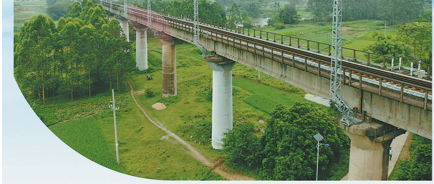
改造完成后的南防铁路。 鲍昌辉 摄
