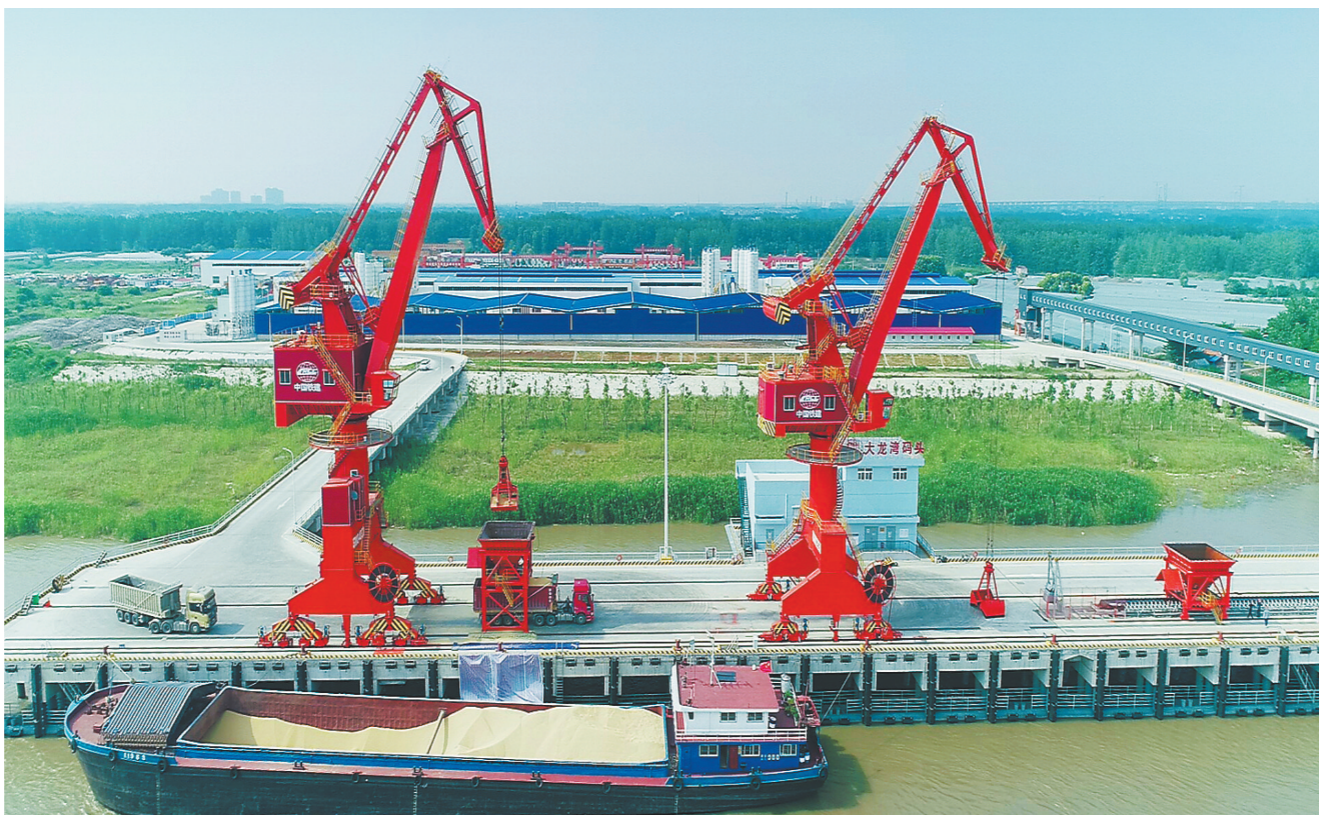
日前,中铁十四局投资建设的芜湖大龙湾码头开通运营。该码头是中国铁建新兴产业项目中首个投入运营的航运码头,位于芜湖市芜湖港白茆港区中铁十四局芜湖大盾构基地内,年货物吞吐量400余万吨。码头将依托中国铁建在长三角地区物资集散和工业化产业基地优势,对中国铁建加快产业集聚、推动经济转型发展具有重要意义。图为码头上正在卸船作业。 唐吉新 摄
