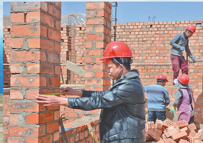
刘印洲正在检查村民安置房工程质量。
