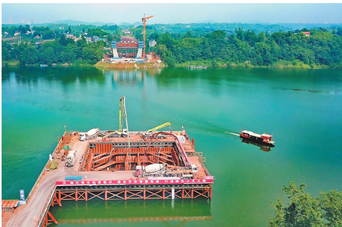
近日,中铁十二局在重庆市合安高速公路渠江特大桥施工中,采取严密防护措施,在江面上搭建了2290平方米的施工平台,使用锁扣式钢管围堰,做到基坑混凝土浇筑不漏浆、平台物件不落水、水面无漂浮物、零污染,保护了渠江的一池清水,受到沿江群众称赞。 武 羽 摄
