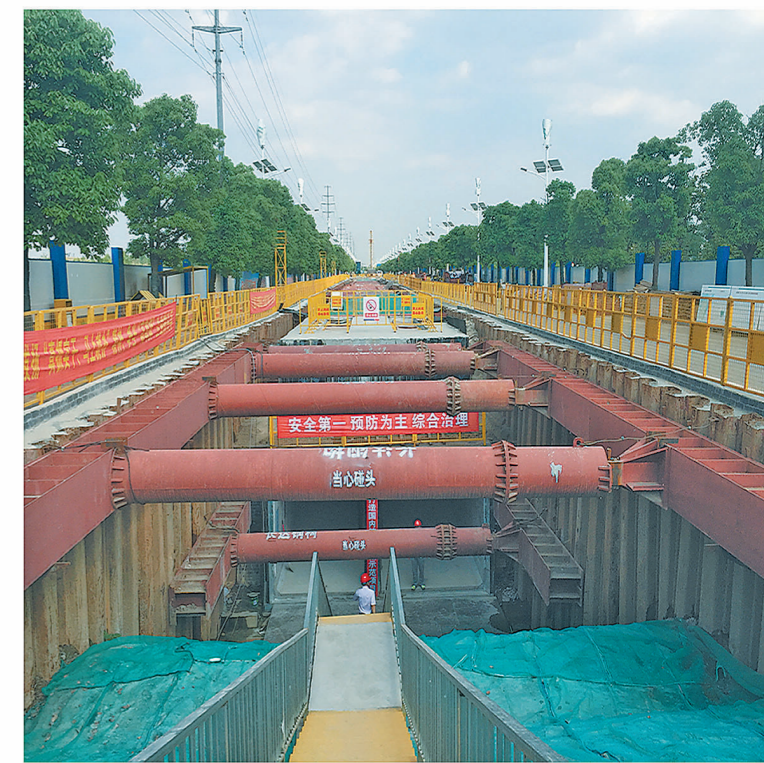
管廊施工现场。
