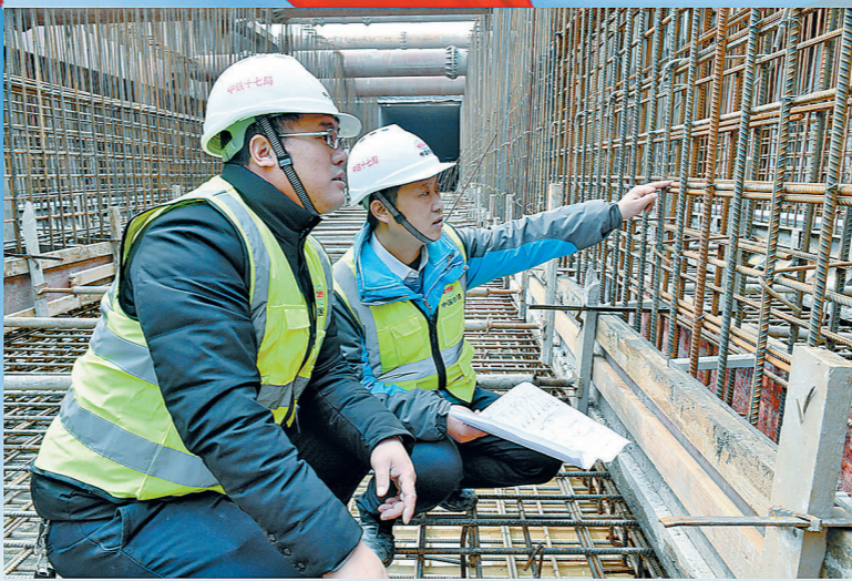
项目管理人员在检查施工质量。
