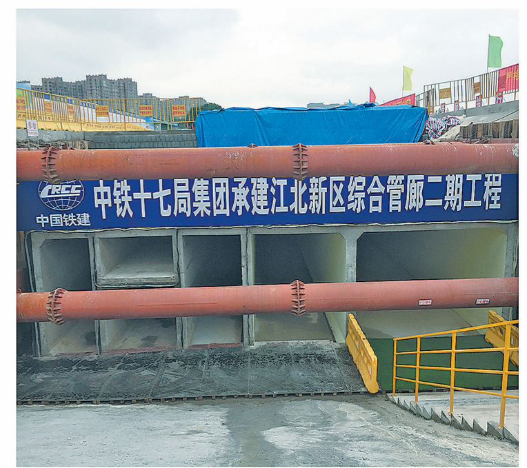
标准化施工现场。
