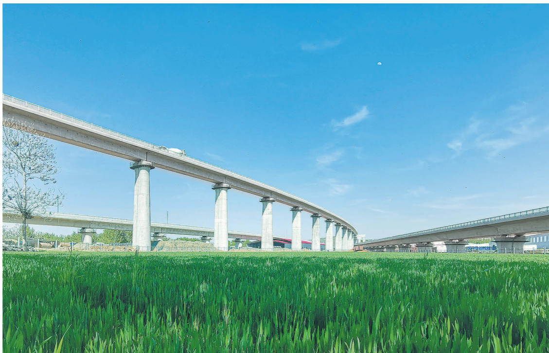
5月27日,由中铁十四局等单位参建的鲁南高铁曲阜段进入静态验收阶段。鲁南高铁东起日照,向西贯穿临沂、曲阜、济宁、菏泽,与郑徐客运专线兰考南站接轨,全长494公里,设计时速350公里,是通往沂蒙革命老区的首条高铁。图为鲁南高铁与京沪高铁联络线相交段。 牟启硕 摄
