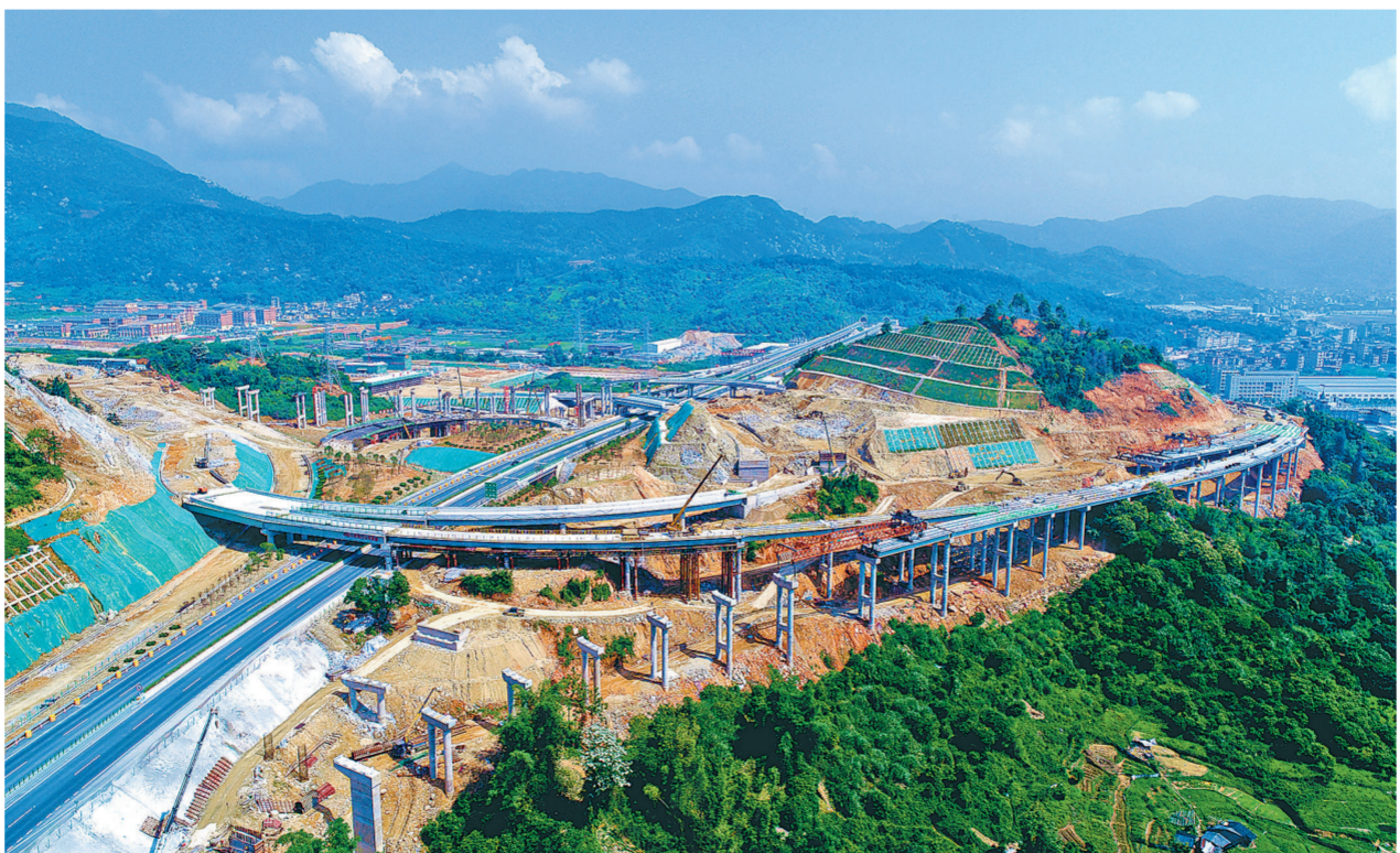
5月29日,由中铁十四局三公司承建的福建省在建最大互通——宁古高速六都复合式枢纽互通坡道最大匝道架梁完成。该互通共设11条匝道,上下4层,4次上跨既有高速公路,为国内少见的小半径、大坡度、复合式曲线匝道桥,架梁最大纵坡为3.7%,是正常架梁坡度的两倍。图为施工中的六都复合式枢纽互通1匝道。 肖永顺 摄
