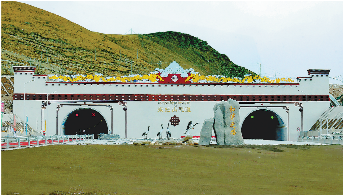
4月25日,由中铁十二局承建的国家重点工程、世界海拔最高的高等级公路——拉萨到林芝公路米拉山隧道(全长5720米)实现双向通车。中铁十二局建设者克服了高原缺氧、围岩松软、突发涌水等困难,圆满完成施工任务。图为米拉山隧道进口。武羽摄
