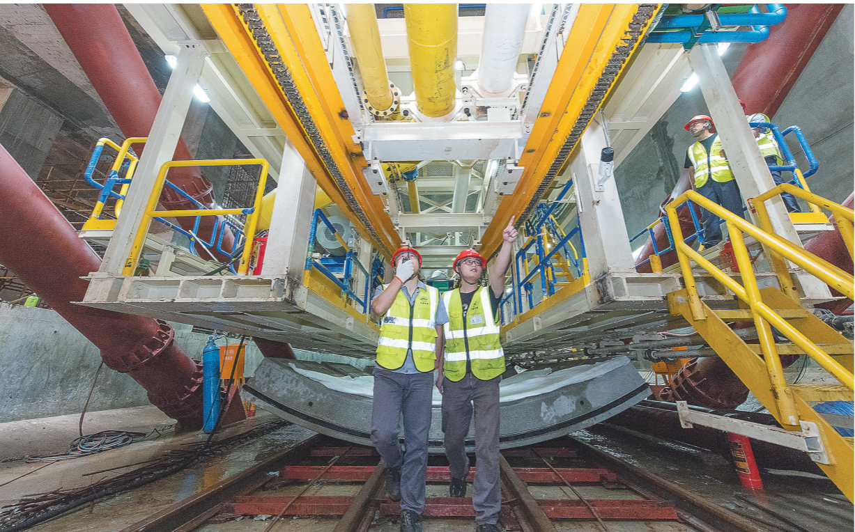
中铁二十二局轨道公司广州地铁18号和22号线项目通过加长洞门钢环宽度,在钢环内圈安装盾尾密封刷进行注浆,实现了洞门双重止水效果,有效克服了广州市富水沙层盾构始发的技术难题。日前,该项目部首台大直径泥水盾构机始发。图为技术人员在讨论解决方案。
