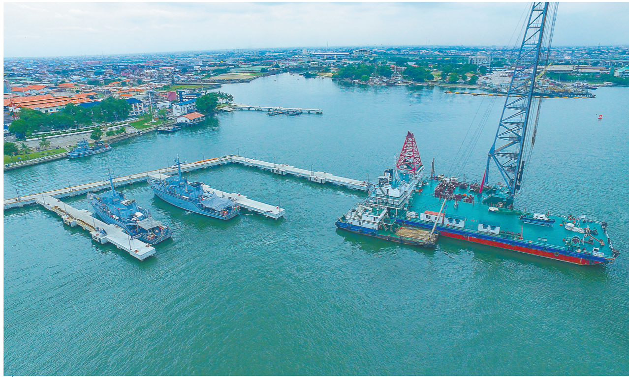
中国铁建港航局践行“海外优先”战略,发挥专业优势,积极参与“一带一路”沿线国家基础设施建设。由铁建桩8、铁建铺01和铁建锚01三艘船舶组成的尼日利亚船队,先后参加了尼日利亚拉各斯军港码头及轻轨跨海桥桩基的施工,并保持安全运行3年零11个月。图为正在进行维修保养的3艘船舶。 朱建华 摄
