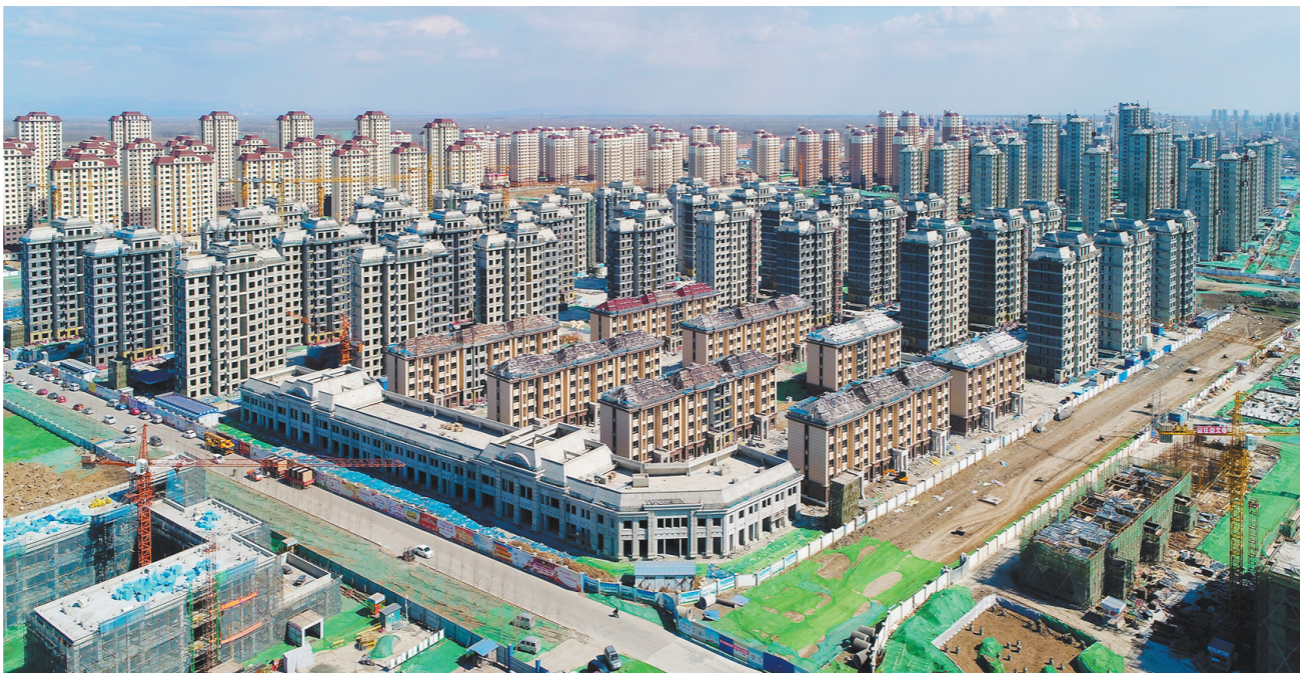
4月9日,由中铁二十二局四公司承建的天津市宝坻区最大棚户区改造工程——气象新苑住宅小区主体结构全部完工,进入装饰装修施工阶段。宝坻气象新苑住宅小区是天津市重点民生工程,总建筑面积28万余平方米,预计今年6月底交付使用,将惠及2156户还迁居民。图为气象新苑住宅小区全貌。
