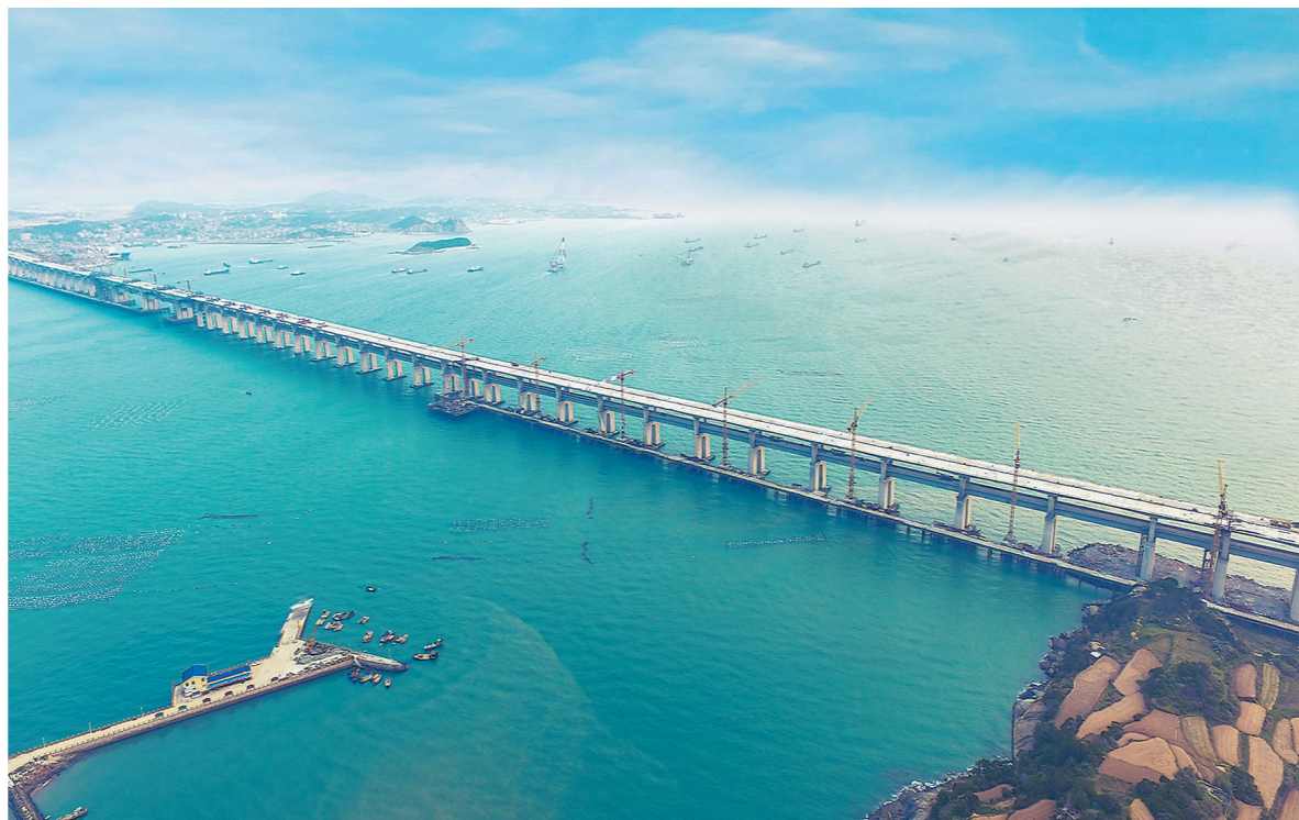
3月30日,由中国铁建大桥局承建的我国首座公铁两用跨海大桥——福平铁路平潭海峡公铁两用跨海大桥大桥岛侧公路梁贯通。福平铁路平潭海峡公铁两用跨海大桥预计2020年全面通车,届时,福州将与平潭形成半小时“经济生活圈”。图为大桥大桥岛侧贯通后的情景。 林 平 摄
