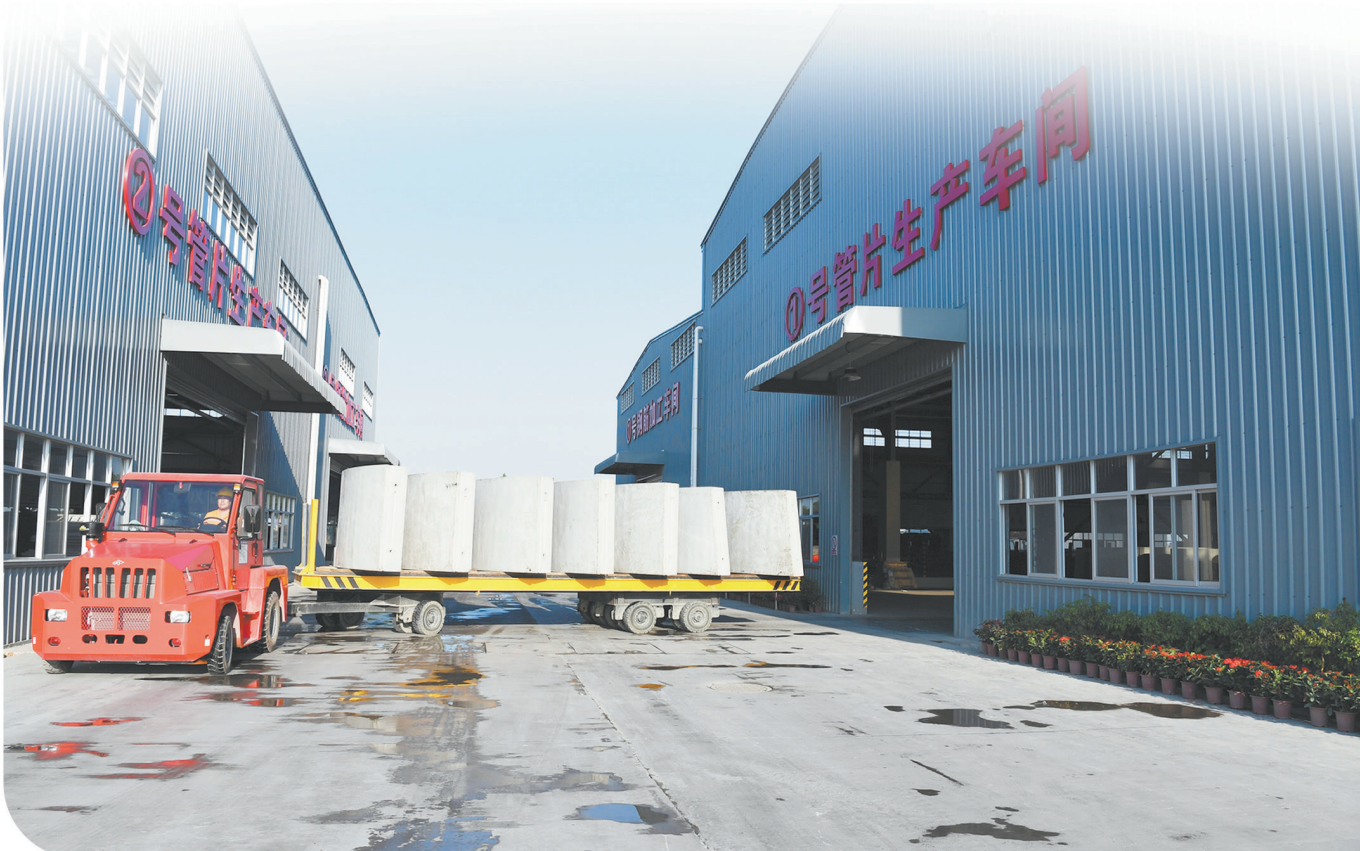
降温后的管片通过平板车运往水养池。
