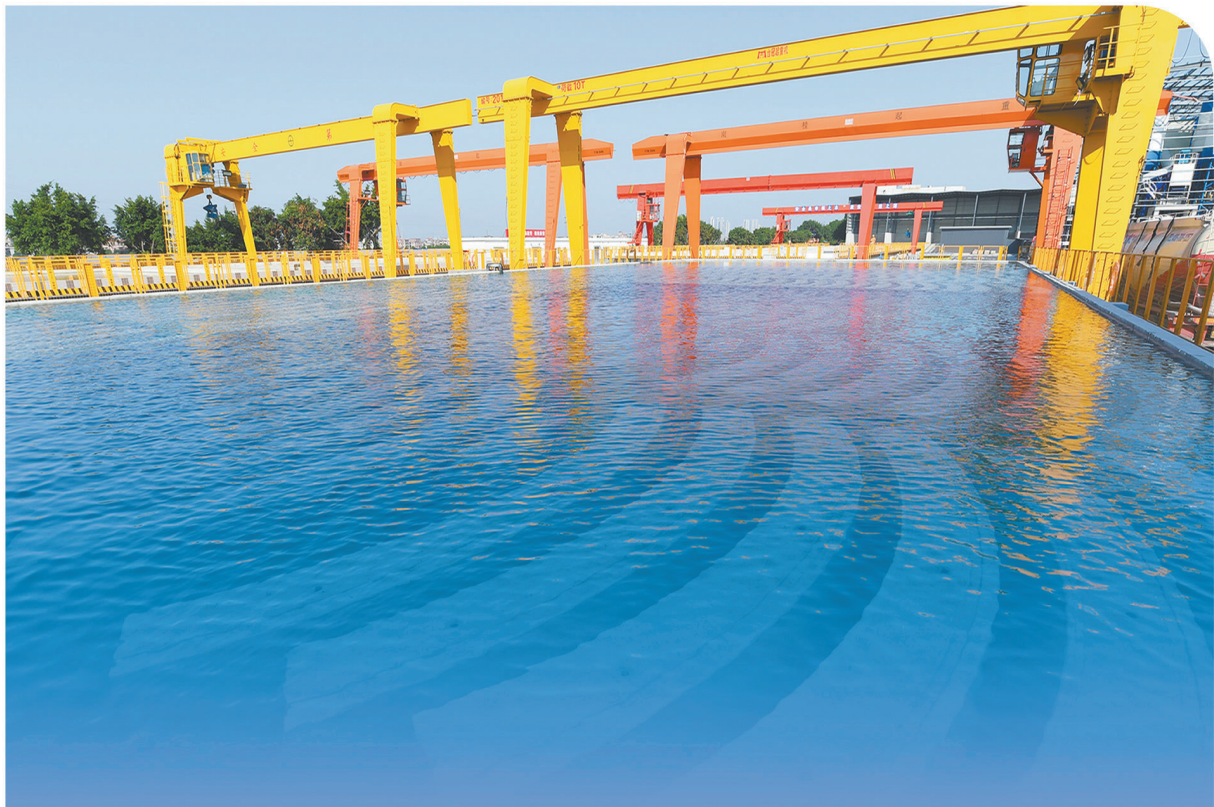
管片在水养池浸泡养护。
