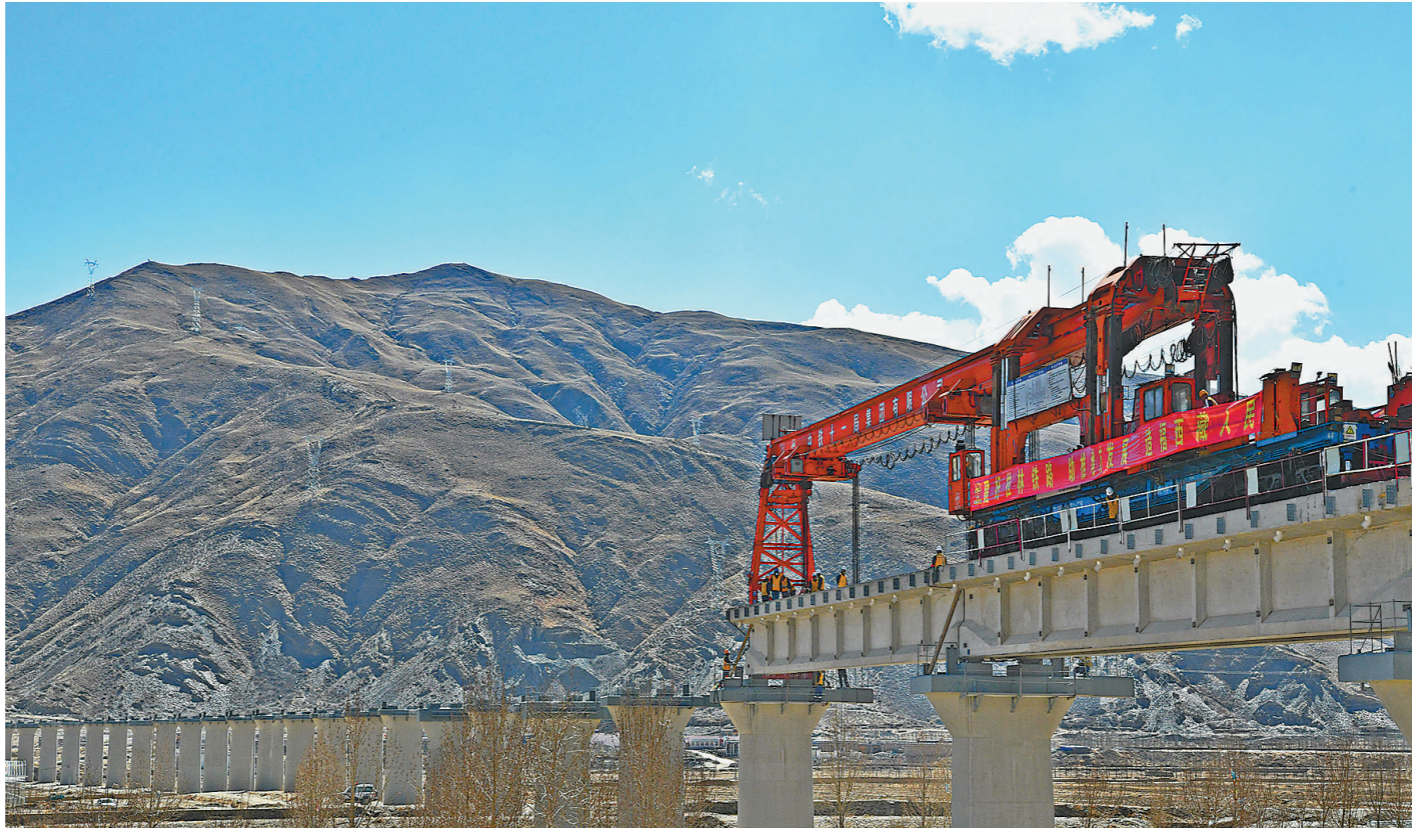
3月19日,拉林铁路首孔声屏障梁成架设在杰德秀1号特大桥上,为后续同类施工积累了经验。杰德秀1号特大桥设计全长1255米,共需架设38孔T梁。为减少列车经过时的噪声污染,承担铺架任务的中铁十一局三公司设计采用18孔声屏障梁,覆盖区域平均降噪达30分贝以上。图为拉林铁路杰德秀1号特大桥架梁现场。 俞文喜 摄
