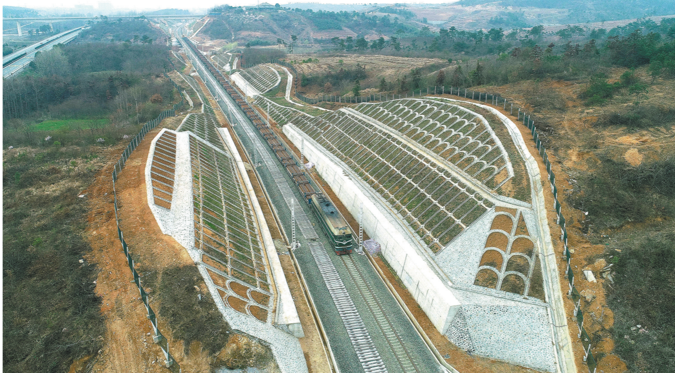
3月17日,由中铁十一局承建的蒙华铁路黄家湾隧道铺轨完成,标志着蒙华铁路湖北段隧道铺轨全部完成。蒙华铁路是世界上一次建成最长的重载煤运铁路,全长1814.5公里,建成后对构建我国“北煤南运”铁路新通道,促进沿线经济社会发展具有重要意义。图为建设者在黄家湾隧道出口铺设500米长轨。金伟摄
