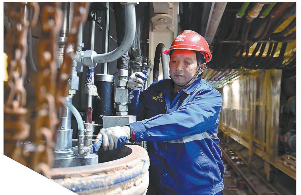
▶老铁道兵郑承贵干工程已经40年,检修设备时认真仔细。图为郑承贵在检修盾尾密封油脂泵。
