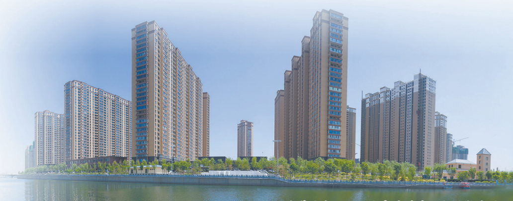
内蒙古包头万郡大郡城瞰中国钢结构金奖。
