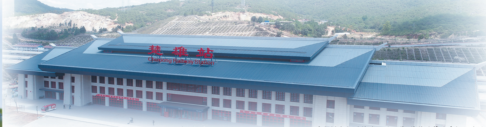
广(通)大(理)铁路开通运营,楚雄站站房投入使用。
