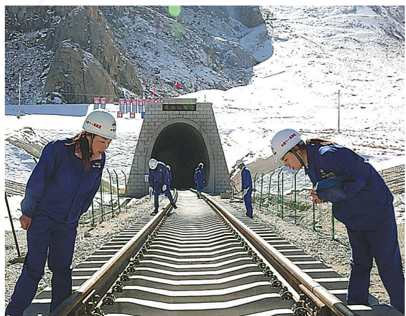
女工班姐妹在检测轨枕质量。 刘清裕 摄
