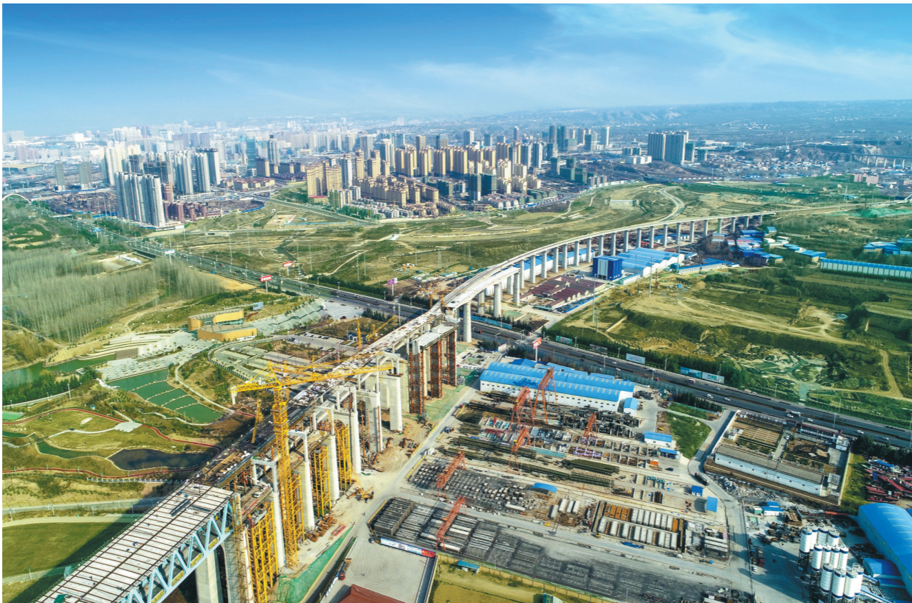
3月5日,由中国铁建大桥局四公司承建的蒙华铁路三门峡黄河公铁两用大桥最后一片T梁架设完成。至此,三门峡黄河公铁两用大桥主体工程已完工,现已全面转入桥面及附属结构施工阶段,向今年10月1日蒙华铁路全线通车迈进坚实一步。图为三门峡黄河公铁两用大桥T梁架设施工现场。李琳琳 摄
