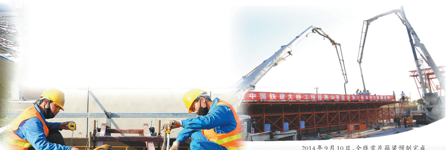
2014年9月10日,全线首片箱梁预制完成
