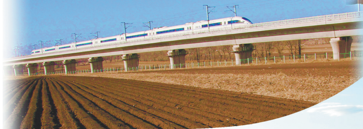
动车组通过高速铁路特大桥
