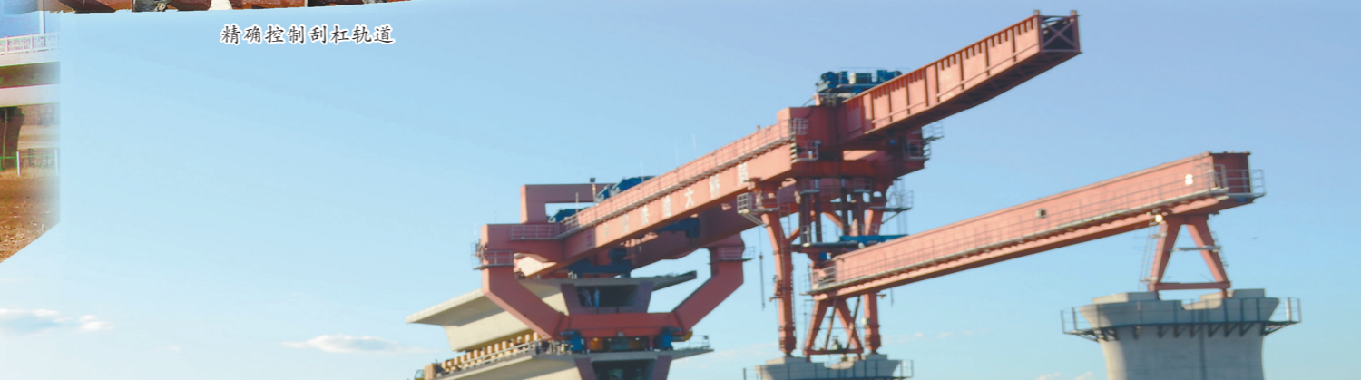
跨高铁铁路特大桥架梁施工
