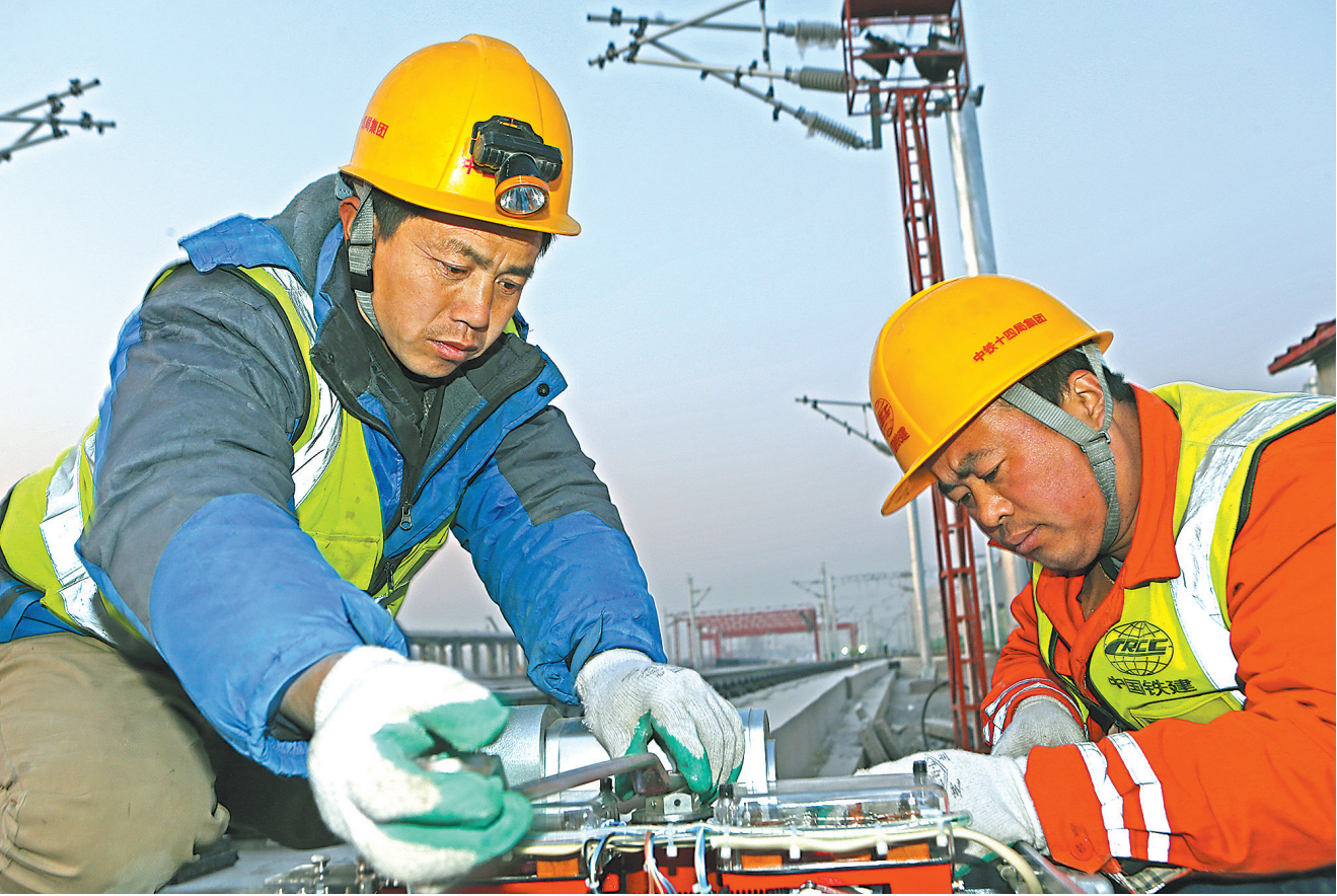
12月27日,由中铁十四局电气化公司承建的北京新机场线停车场信号系统联锁开通,作为全线首个车站开始车辆冷滑实验,开启国内首条160公里时速地铁动车调试。图为工人检查停车场电动转辙机,为信号联锁开通做最后的道岔调试。
