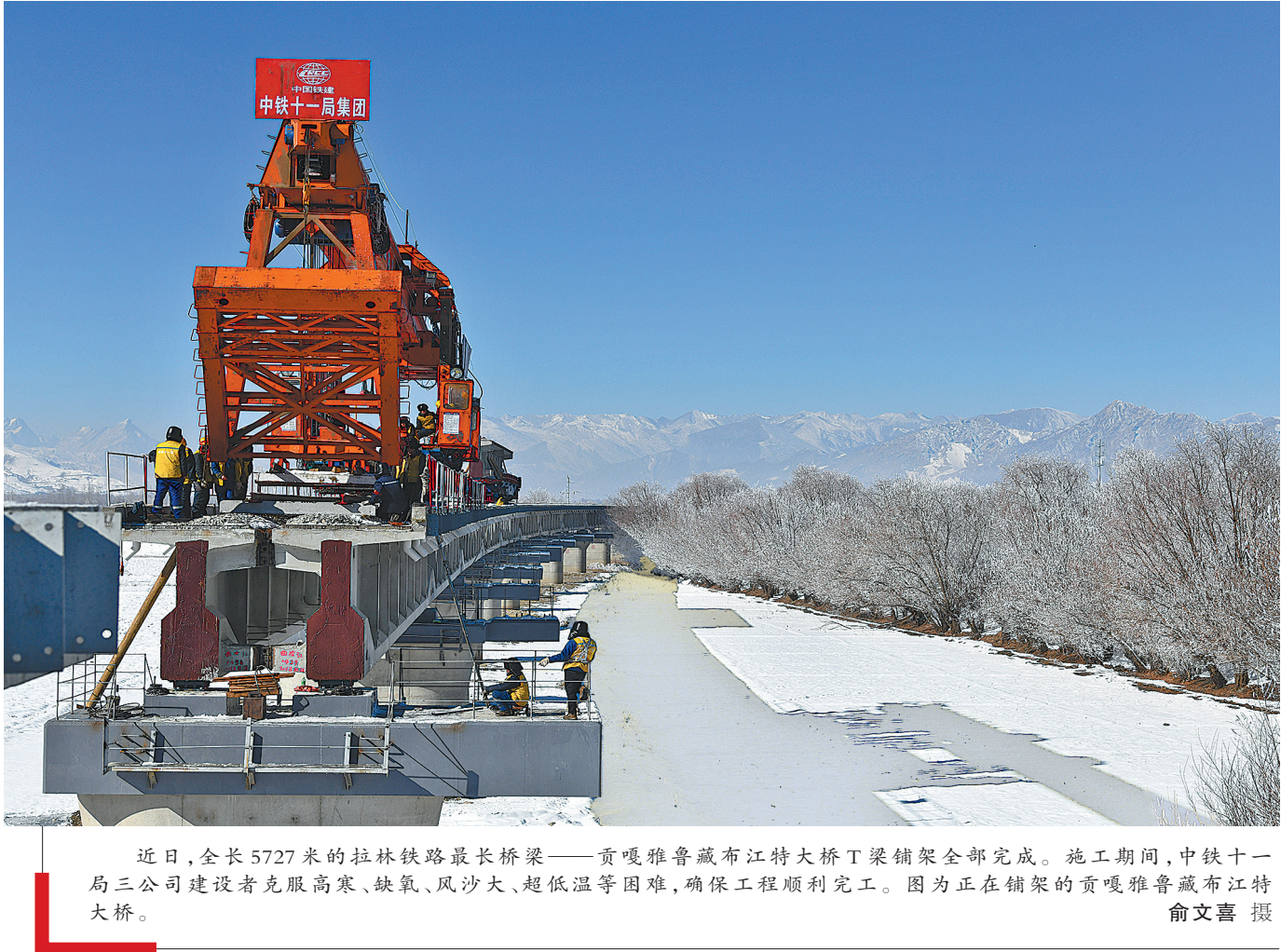
近日,全长5727米的拉林铁路最长桥梁——贡嘎雅鲁藏布江特大桥T梁铺架全部完成。施工期间,中铁十一局三公司建设者克服高寒、缺氧、风沙大、超低温等困难,确保工程顺利完工。图为正在铺架的贡嘎雅鲁藏布江特大桥。
