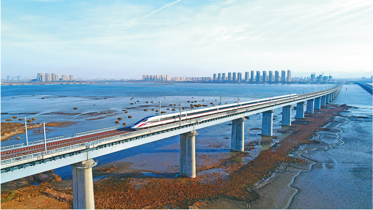
12月26日,由中铁十一局、中铁十二局、中铁十四局参建的我国“八纵八横”高速铁路网的重要组成部分——全长428公里的青盐铁路正式建成通车,结束了日照、连云港、盐城不通动车的历史,青岛至上海的列车运行时间将由7个小时缩短至4个小时。图为首列动车从跨胶州湾特大桥上快速驶过。
