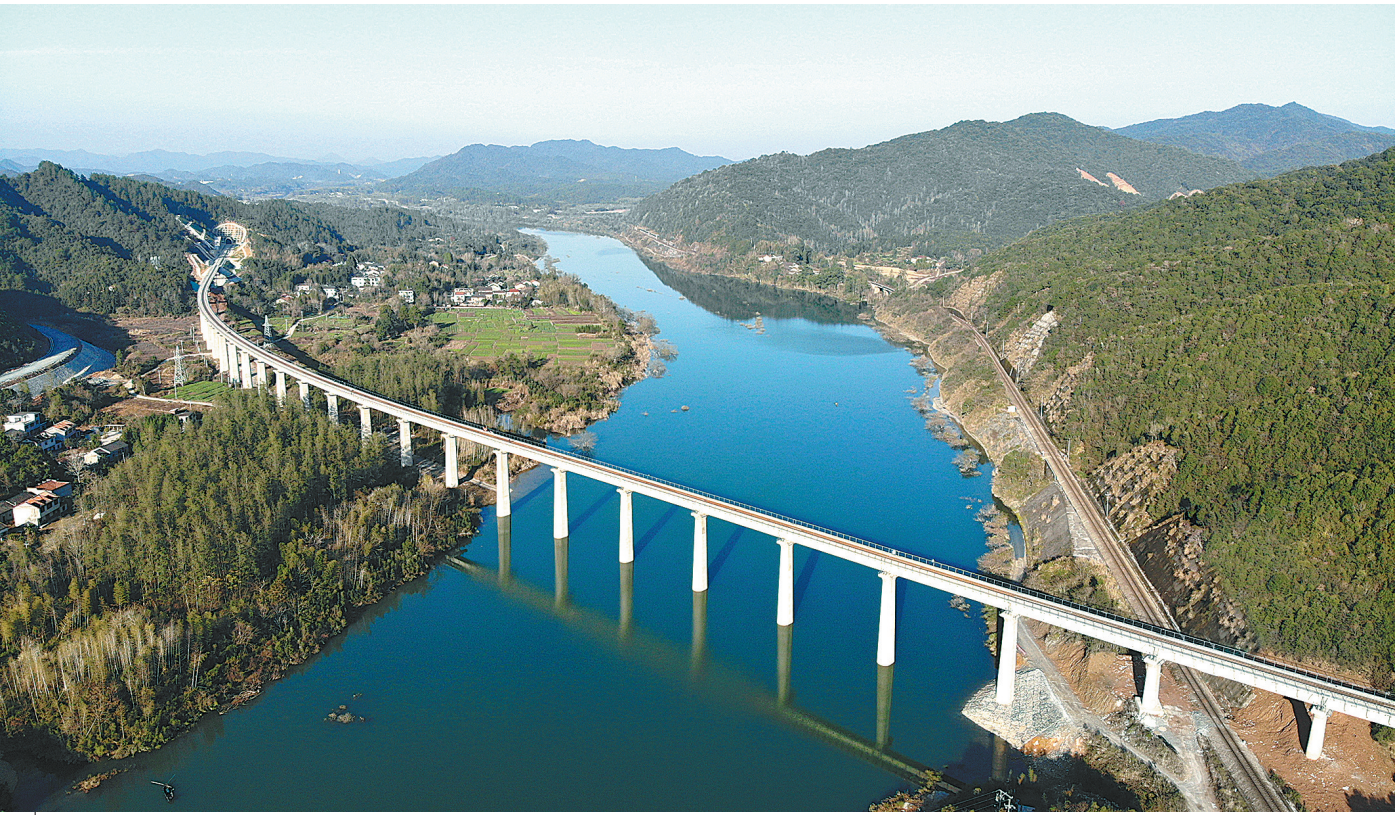
12月20日,由中铁二十五局承建的皖赣铁路涠溪口水库改线工程正式开通运营,为全国重大水利工程项目涠溪口水利枢纽建设扫清了障碍,将进一步提升“瓷都”景德镇的防洪能力。图为涠溪口水库改线工程昌江特大桥。郭洮摄
