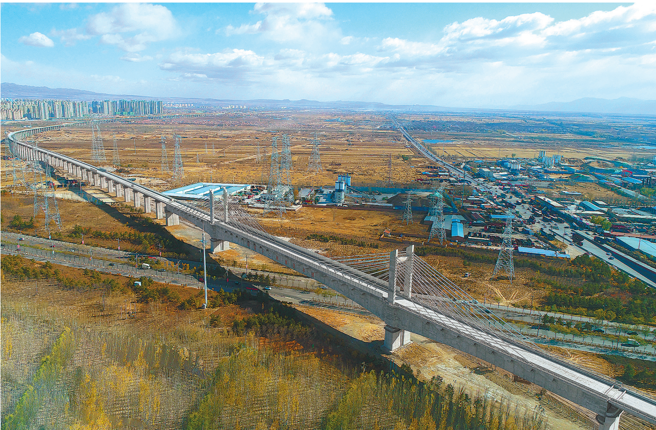
日前,由中铁十二局四公司承建的大(同)张(家口)高铁智家堡御河特大桥完工。该桥全长13.6公里,是全线最长桥梁,也是目前亚洲矮塔斜拉结构桥梁中单体梁跨度最大的铁路桥。
