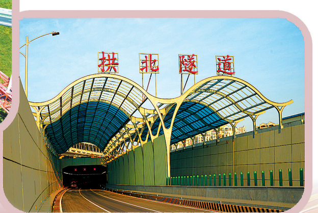
▼港珠澳大桥连接线拱北隧道首次采用“曲线管幕+冻结法”施工,攻克了超长、超大管幕施工中的一系列世界级难题。该工程入围国际隧道与地下空间协会2018年度杰出工程。伍振 摄
