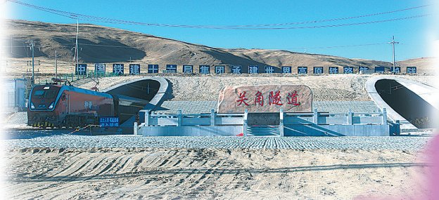
新关角隧道是目前世界高海拔第一长隧,先后获得国际隧道及地下空间协会最高奖“年度重大工程奖”和詹天佑奖。邓昆伦 供图
