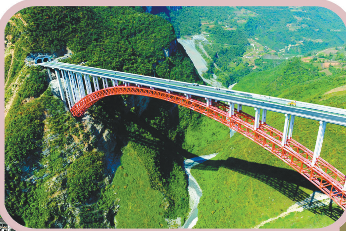
▲沪蓉西高速公路支井河特大桥是目前世界最大跨度上承式钢管拱桥,获得鲁班奖和詹天佑奖。陈树青 摄
