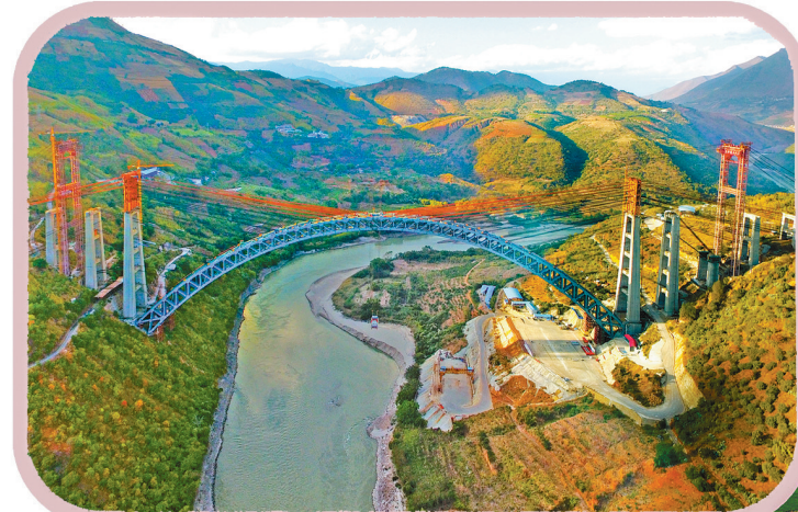
近日,世界最大跨度铁路拱桥——大瑞铁路怒江四线特大桥实现钢桁拱合龙。伍振 摄
