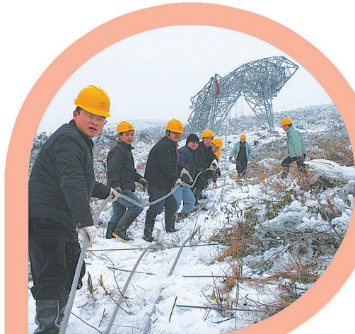
图为2008年我国南方发生雪灾,中国铁建电气化局抢险队在京广铁路湖南段参加抗冰抢险。 葛建军 摄
