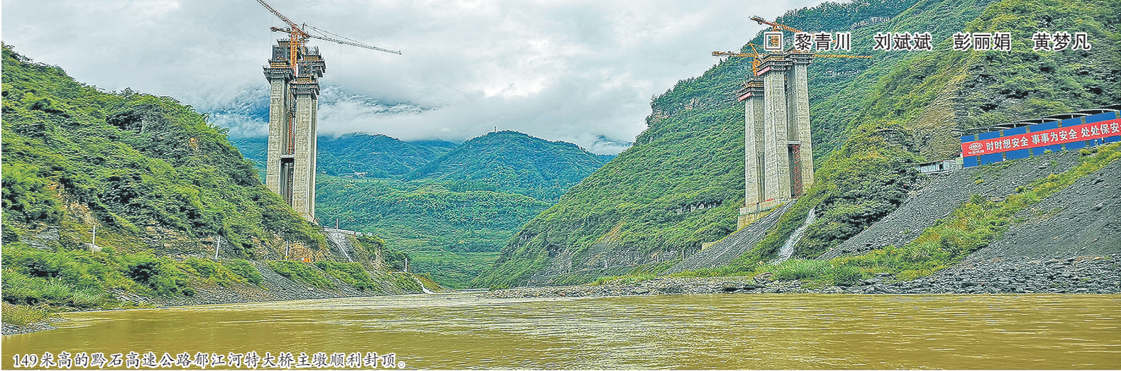
149米高的跨石高速公路郁江河特大桥主墩顺利封顶。
