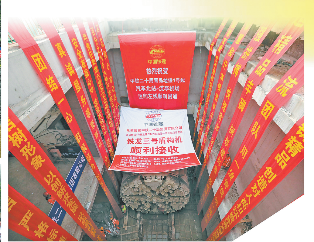
该公司承建的青岛地铁1号线气流区间实现双线贯通。
