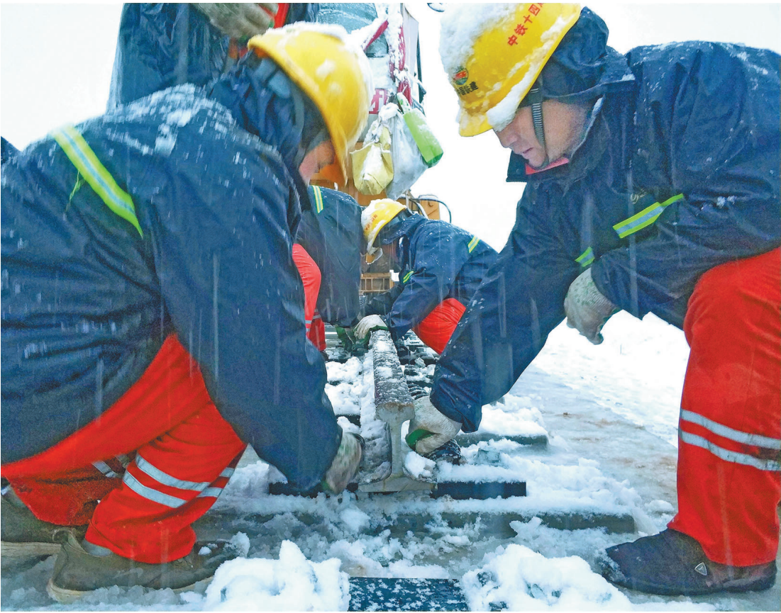
由中铁十四局参建的鲁南高铁是山东省现有建设里程最长、投资规模最大、建设条件最复杂和沿线人口最多的高速铁路。为保证明年底该高铁日照至曲阜段开通运营，建设者们 在寒冬中掀起大干热潮。图为山东大部地区日前迎来了入冬第一场雪，五公司建设者在蒙山站附近冒雪进行铺轨作业。
