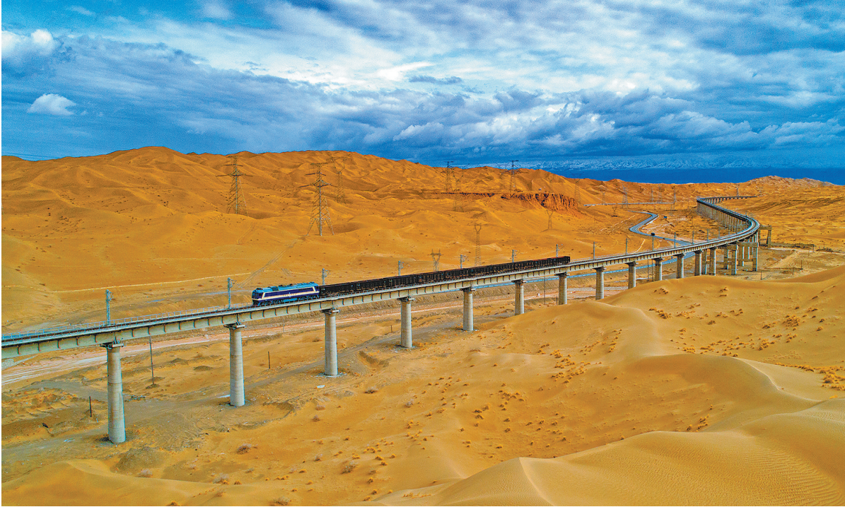
近日,由中铁十一局承建的敦(煌)格(尔木)铁路沙山沟特大桥获得2018-2019年度国家优质工程奖。沙山沟特大桥全长10.604公里,位于酒泉市阿克塞哈萨克族自治县境内,是我国唯一一座穿越活动性沙漠地区的特长桥梁。图为沙山沟特大桥。金伟摄
