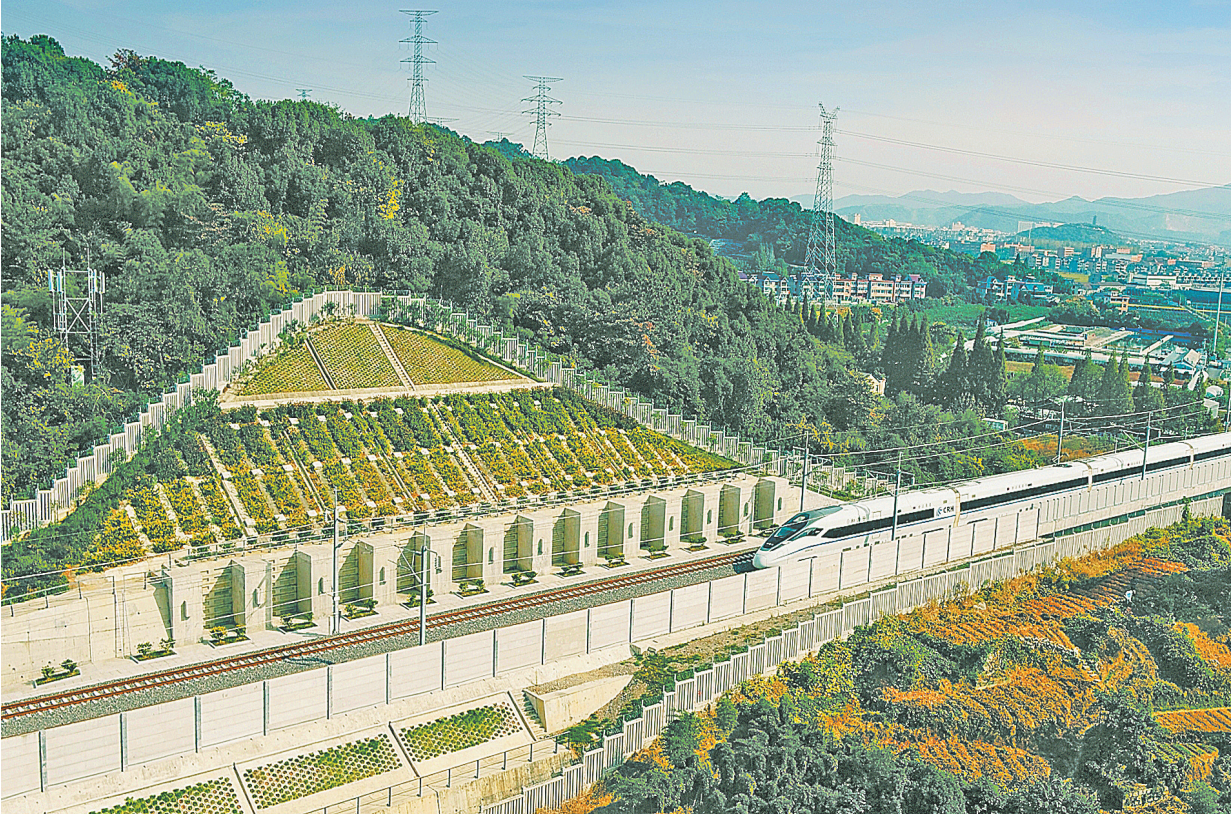
日前,杭(州)黄(山)铁路联调联试进入最后阶段,试运行动车经过中铁二十四局承建的标准化工路基段。此段路基位于半山腰上,建设者坚持“环保与建设同步,建设与环保同行”的理念,在施工中采用浇灌养护、施肥保暖等方式保护边坡苗木,实现了工程建设与生态环境相融共生。
