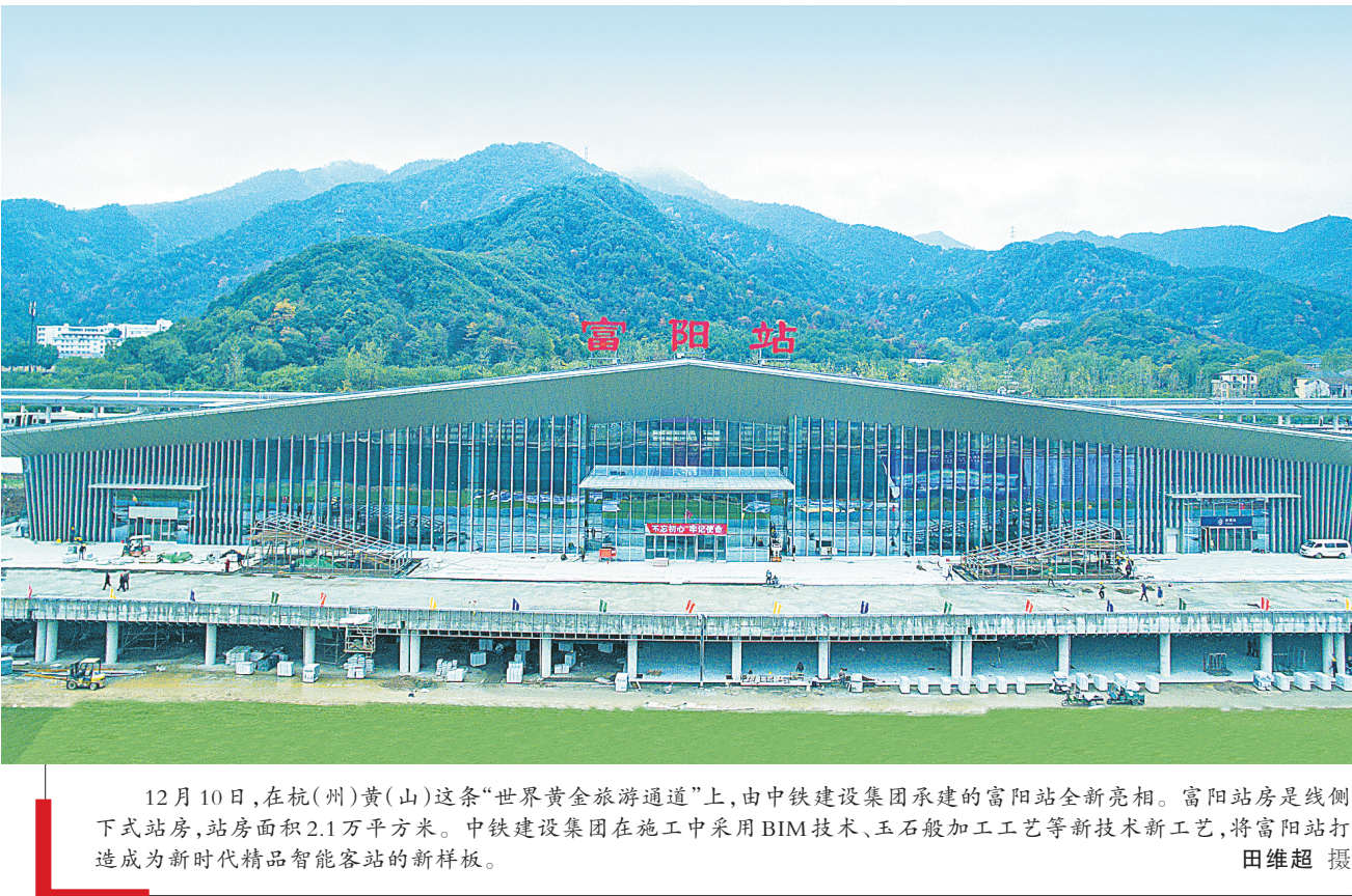
12月10日,在杭(州)黄(山)这条“世界黄金旅游通道”上,由中铁建设集团承建的富阳站全新亮相。富阳站房是线侧下式站房,站房面积2.1万平方米。中铁建设集团在施工中采用BIM技术、玉石般加工工艺等新技术新工艺,将富阳站打造成为新时代精品智能客运站的新样板。
