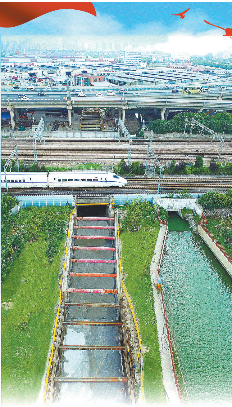
涞坊路至沪星路道路新建工程下穿铁路、市政道路。
