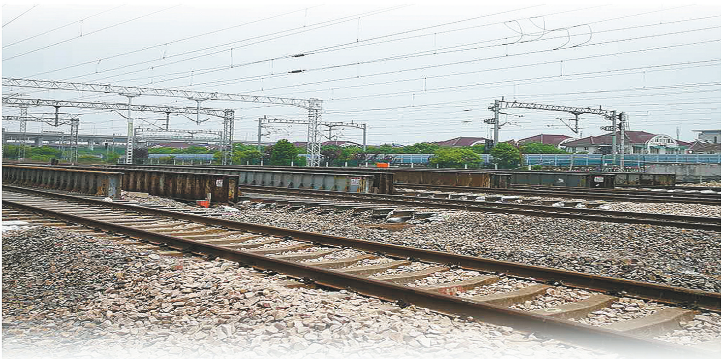
涞坊路至沪星路道路新建工程铁路轨道便梁架设施工。
