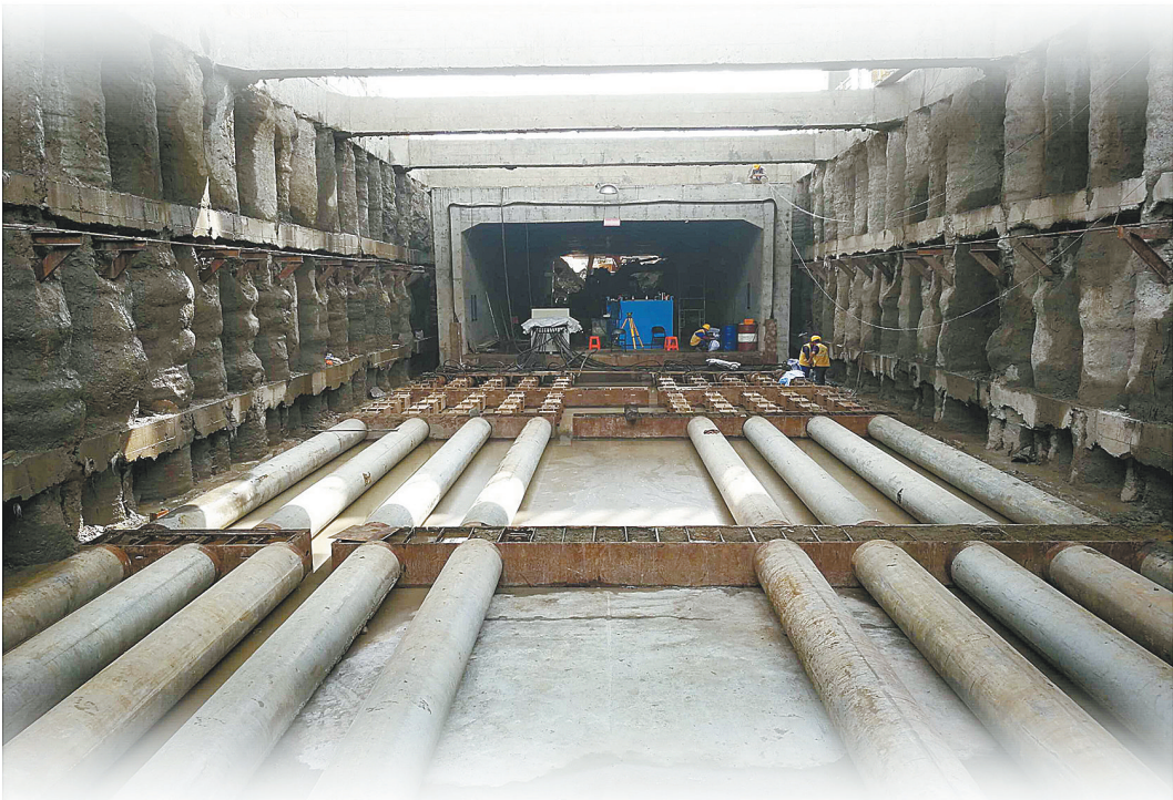
涞坊路至沪星路道路新建工程下穿铁路的箱体顶进施工。
