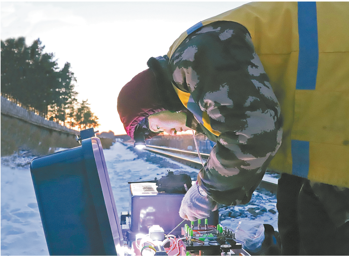
近日，由中铁二十三局电务公司负责施工的齐齐哈尔至北安铁路克东站信号联锁设备改造工程一次性通过验收，为全线顺利开通奠定了基础。该公司在施工中推行高铁标准的施工工艺，实现了无返工零缺陷。图为克东站封锁施工时，青年员工在认真调试轨道设备。王 鹏 摄
