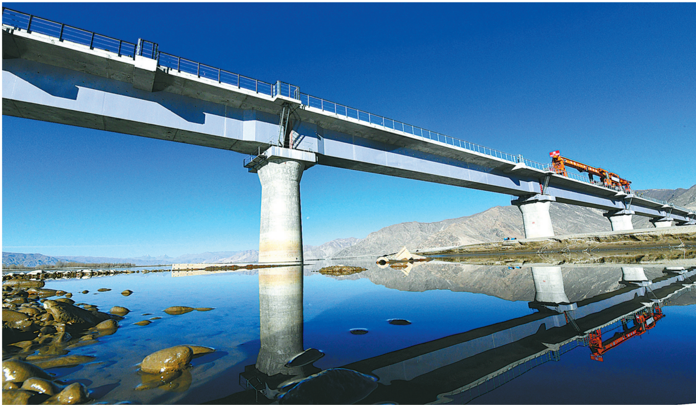
11月26日,由中铁十一局三公司参与建设的川藏铁路拉林段首座跨江大桥——贡嘎雅鲁藏布江特大桥开始铺架。川藏铁路拉林段全长435.48公里,贡嘎雅鲁藏布江特大桥是川藏铁路拉林段最长桥梁,也是首座横跨雅鲁藏布江的桥梁。此次铺架标志着川藏铁路拉林段迈出跨江第一步。图为正在铺架中的贡嘎雅鲁藏布江特大桥。 俞文喜 摄
