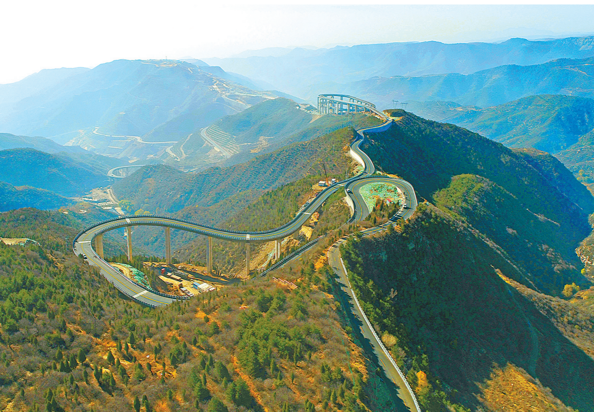
日前，由中铁十二局承建的太原市天龙山区域防火旅游通道工程主线完工。该旅游通道将太原市的6个著名景区串联起来，是太原市旅游经济带的核心干线之一。天龙山区域防火旅游通道工程集观光旅游、文物保护和森林防火于一体，建成后将成为当地旅游经济新的增长点。 丁明明 摄
