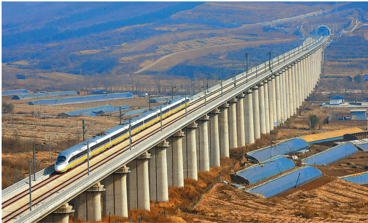
近日,由中铁十二局参与建设的京沈高铁沈阳至承德段跨省界段迎来联调联试,为年底该段开通运营奠定了基础。京沈高铁全长698公里,开通后北京到沈阳将缩短至两个半小时。图为检测车正行驶在辽宁段凌源市大王杖子特大桥上。 武羽摄
