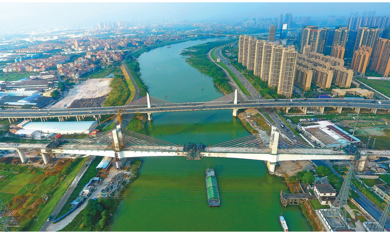
11月16日,由铁一院设计、中铁十二局承建的国内在建城际铁路无砟轨道最大跨度矮塔斜拉桥——广东省珠三角广佛城际铁路东平水道矮塔斜拉特大桥合龙。该桥全长4869米,主跨为(96+176+96米)双塔双面临预应力混凝土斜拉索,跨越东平Ⅱ级航道。它的合龙,不仅使全长35公里的广佛城际铁路桥梁形成闭合,也为明年全线如期开通奠定了基础。图为东平水道矮塔特大桥主桥。 武羽摄
