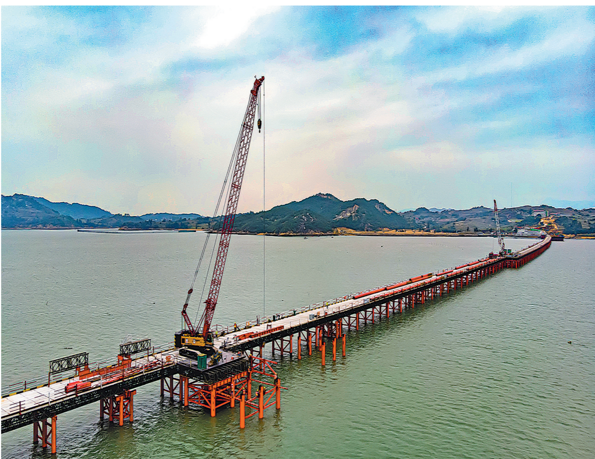
新建福州至厦门高速铁路是我国首条跨海高铁，全长277.42公里，设计时速350公里。中铁十一局一公司承建的涠洲湾跨海大桥钢栈桥全长14.701公里，其中海域部分长10.8公里，是全线重难点工程。图为建设者在进行涠洲湾跨海大桥钢栈桥施工。 金伟摄
