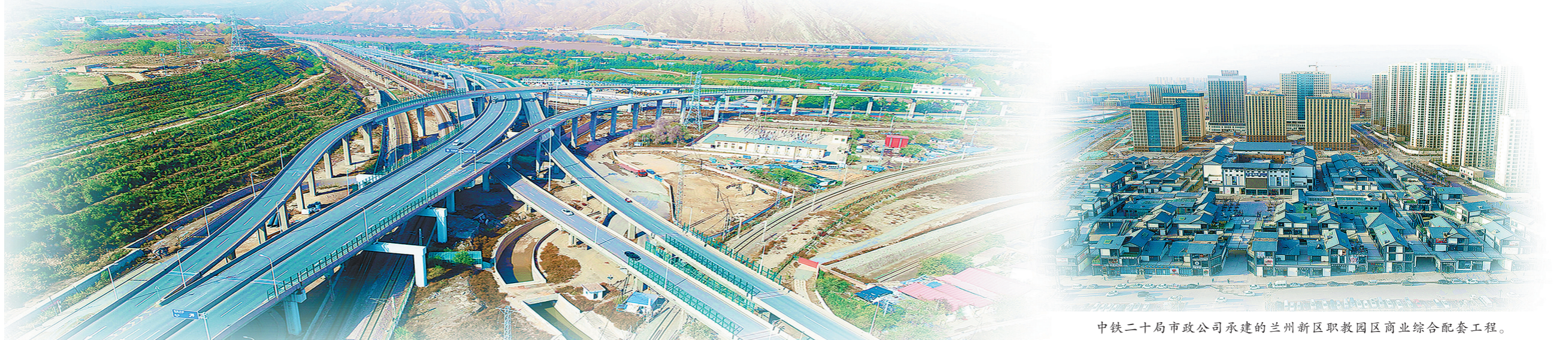
中铁二十局市政公司承建的兰州市南山路西柳沟立交。
