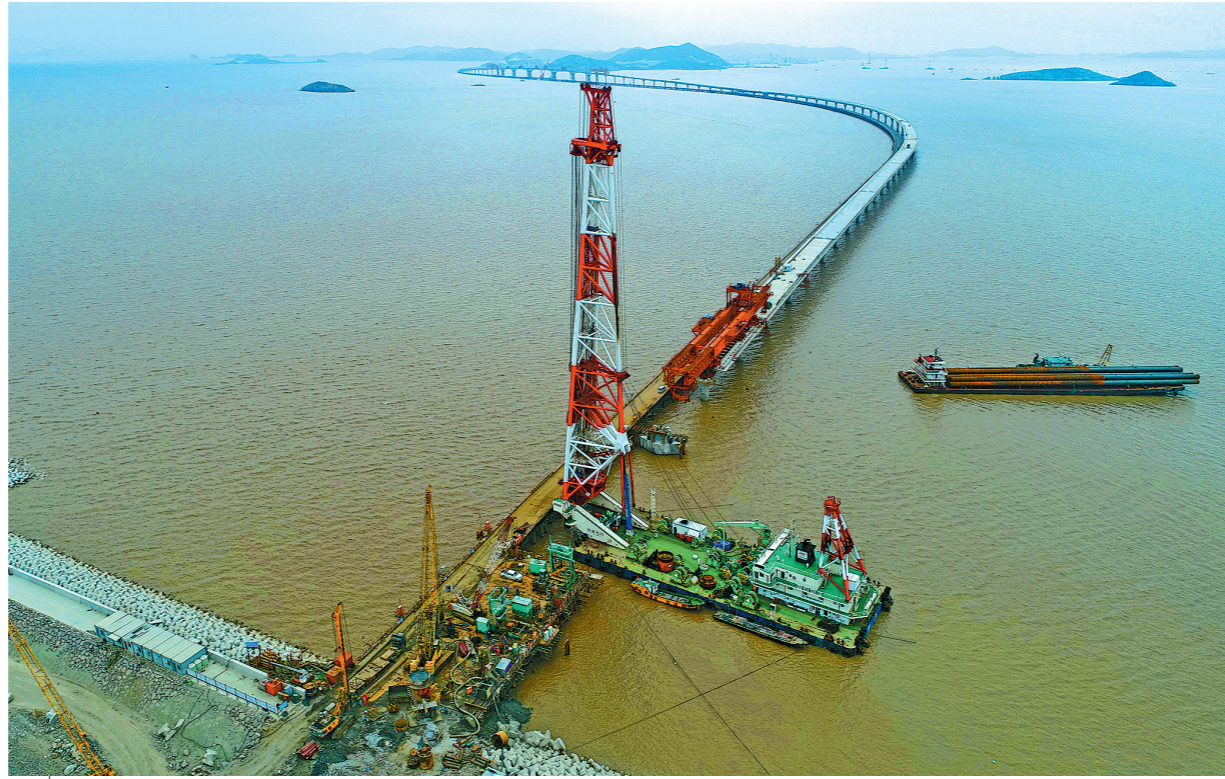
11月13日,由中国铁建港航局二公司承建的鱼山液化码头项目鱼山大桥引桥段工程钢管桩施工圆满完成。该工程是“十三五”期间国家重点打造的七大世界级石化基地之一舟山绿色石化基地的重要组成部分,也是浙江省定位建立国际石化产业基地的重要支撑工程,建成后有助于提高浙江省石化产业综合竞争力,助力舟山成为全球规模最大、最具竞争力的石油仓储物流基地。图为“铁建桩01”在进行打桩作业。 徐启欢 摄
