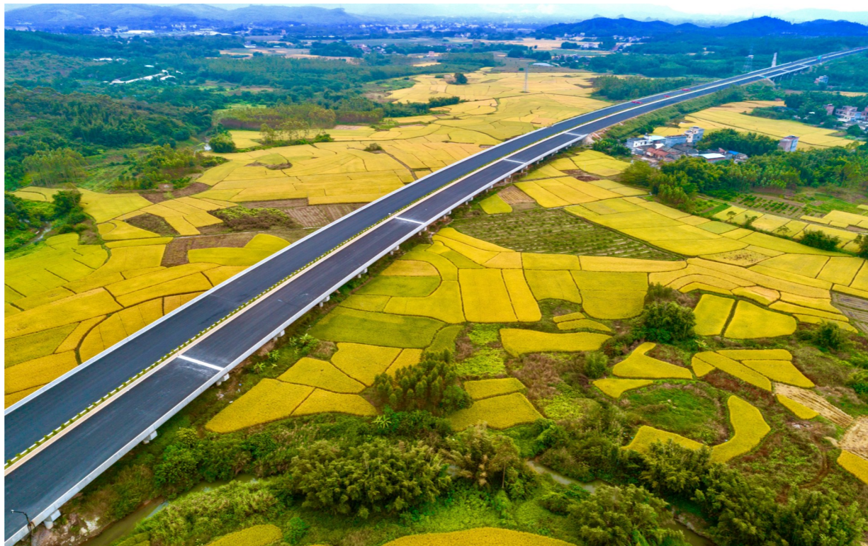
由中铁十四局承建的武(汉)深(圳)高速公路沿线自然生态和旅游资源丰富,为呵护青山绿水,项目部针对路基边坡提出“弧形边坡”理念,最大程度还原山体地貌,还将桥梁工程的桥底裸露地表进行了绿化,建设了一条绿色环保旅游高速公路。图为武深高速公路新桥段。 王观生 摄
