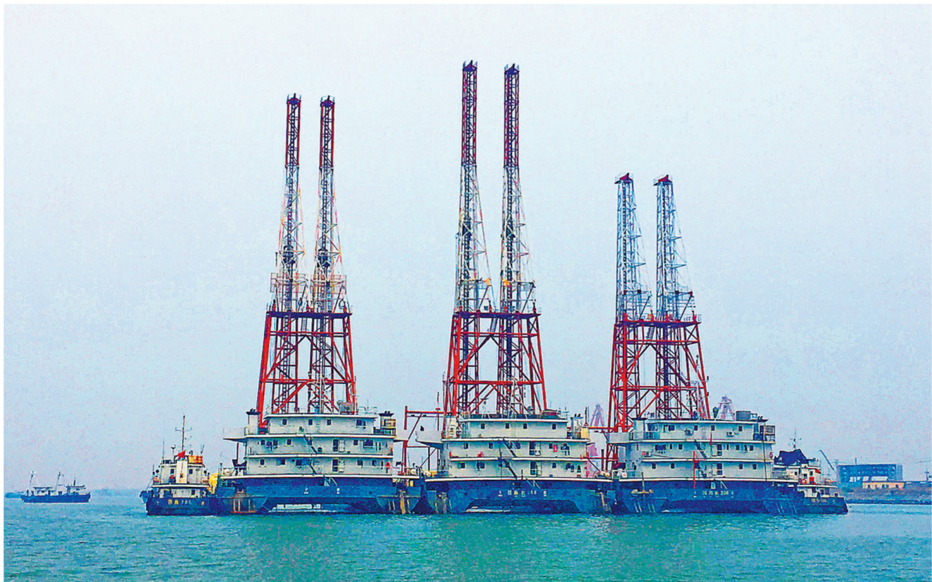
近日,由中国铁建港航局承建的交通运输部水运“十三五”发展规划重点项目——东营港东营港区进港航道及导堤工程SG-2标排水板打设总量突破100万延米。该工程是山东东营港建设亿吨大港的重要组成部分,也是山东省发展高端石化产业基地的重要支撑项目,建成后有助于提升东营港核心竞争力,带动黄河三角洲地区经济快速发展。图为插板船在进行搭设作业。
