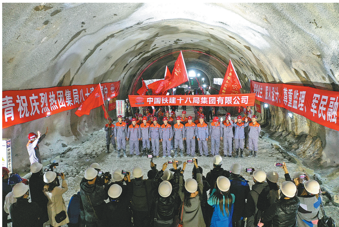
青岛地铁1号线海底隧道全长8.1公里,最低点距离海平面88米,是国内首条地铁海底隧道,也是国内最深的海底隧道和最长地铁海底隧道,中国铁建和十八局以联合体模式参与施工建设。图为11月6日,中铁十八局青岛地铁1号线海底隧道项目部参建员工欢庆隧道贯通。 崔风华 文 王强强 摄
