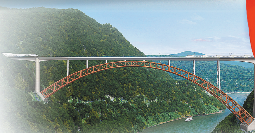
国内最大跨度、最大高差的非对称上承式钢管混凝土桁架拱桥——主跨292米的西水大桥。
