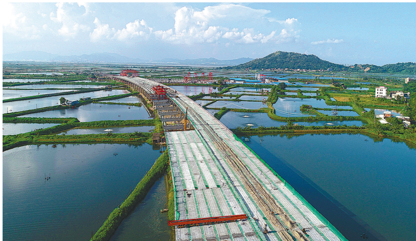
中铁十八局一公司潮汕环线项目部在河溪2号高架桥施工中,为避免泥浆对河道环境造成污染,利用新工艺新技术对施工污水和生活污水进行净化处理,达到标准后方可排放。项目进场两年多来,工地周边依然是花草丛生,河水清澈,受到当地政府和百姓好评。图为建设中的河溪2号高架桥。张向辉 摄
