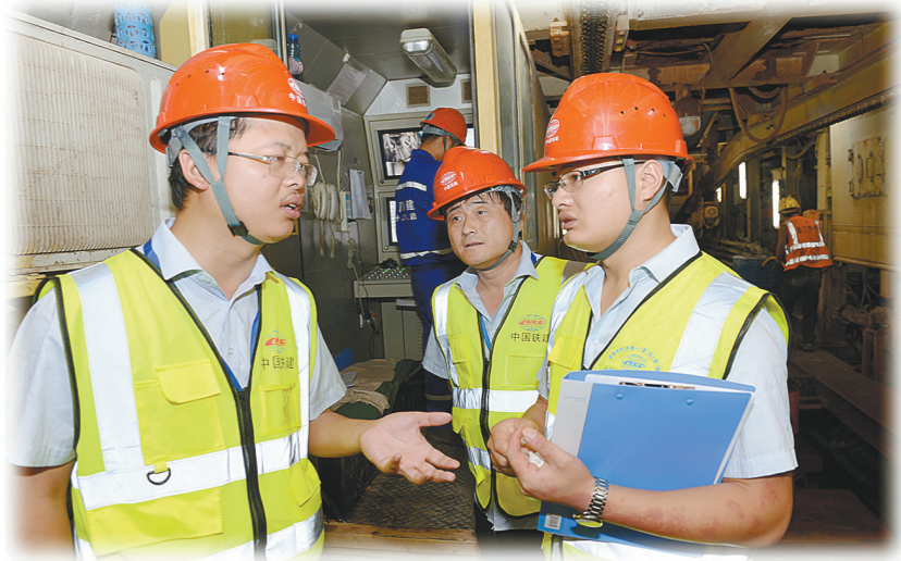
项目部技术人员在盾构掘进现场查看施工生产情况。
