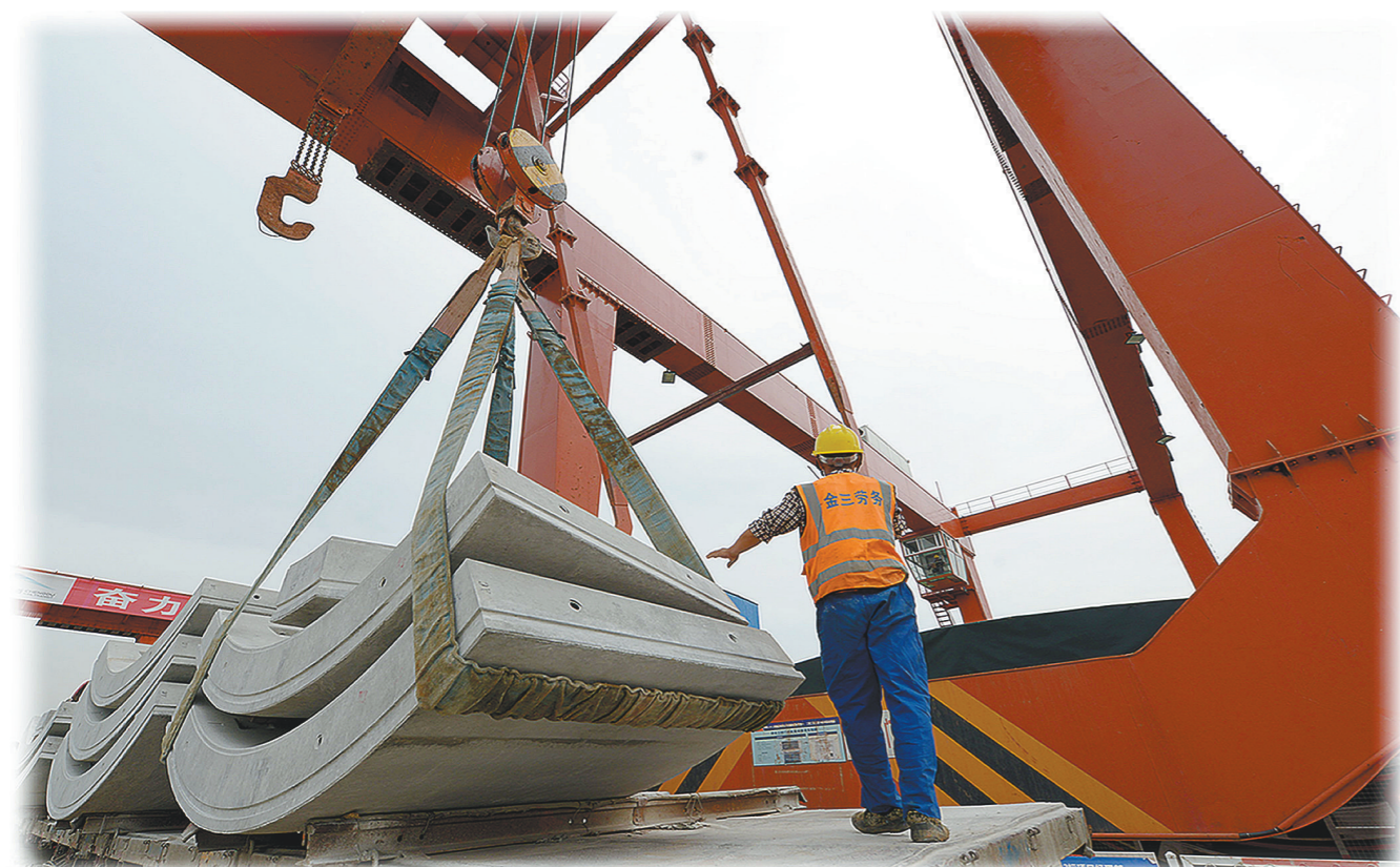
工人在吊装盾构区间管片。
