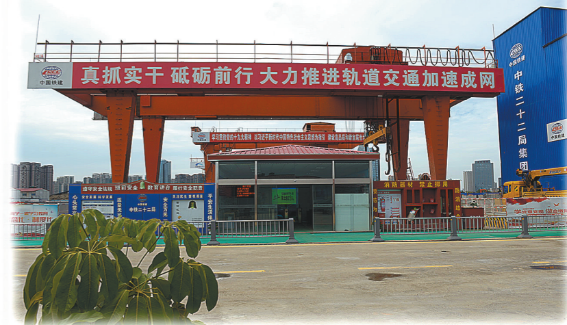
成都地铁6号线三色路站施工现场。
