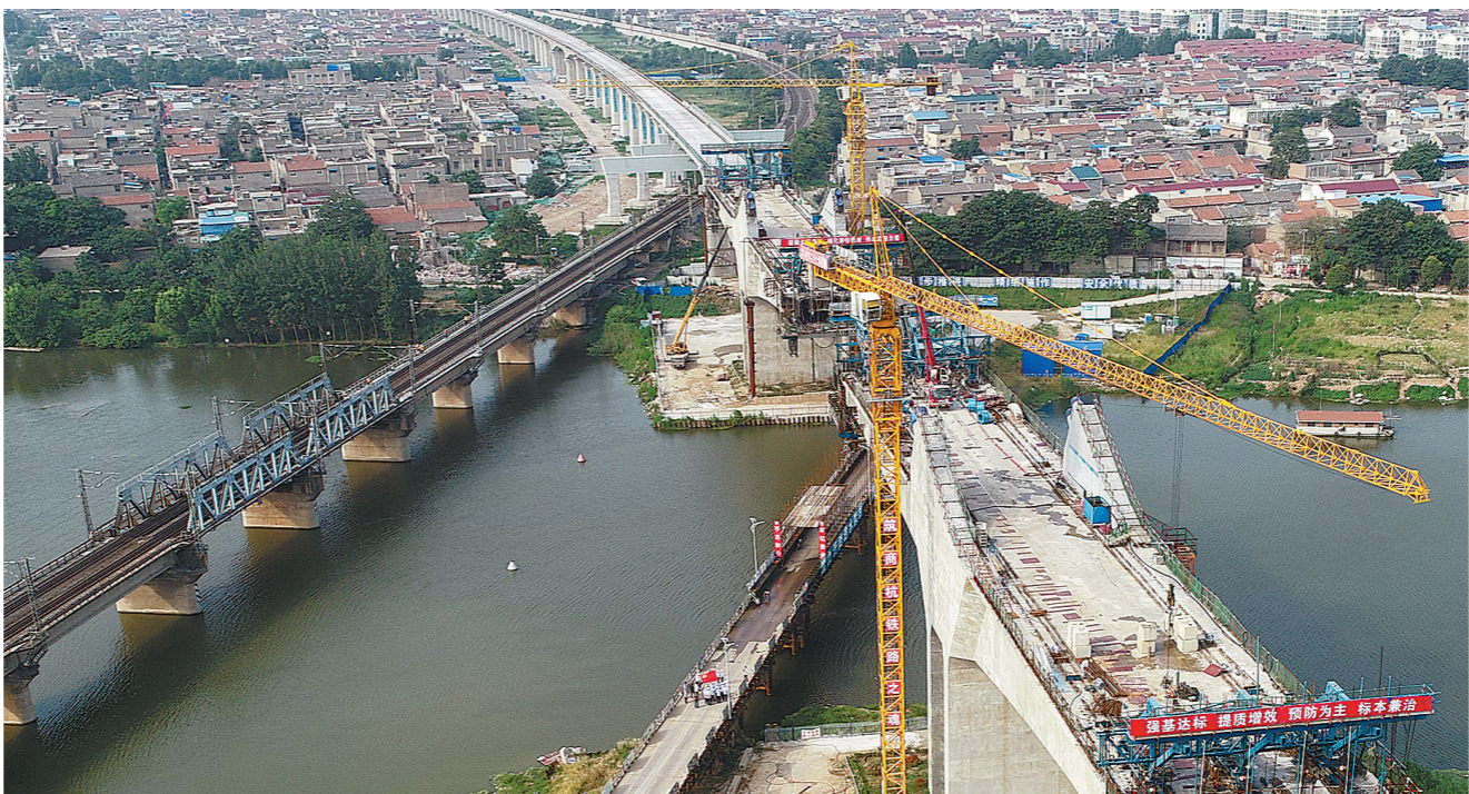
10月20日,由中铁二十一局承建的商合杭高铁亳州特大桥跨涡河连续刚构主体顺利合龙,至此亳州特大桥全部贯通。亳州特大桥长18.4公里,其中长345.8米的跨涡河连续刚构位于四级通航河流上,主跨168米,该桥是全线重难点工程。图为亳州特大桥跨涡河连续刚构主跨施工现场。
