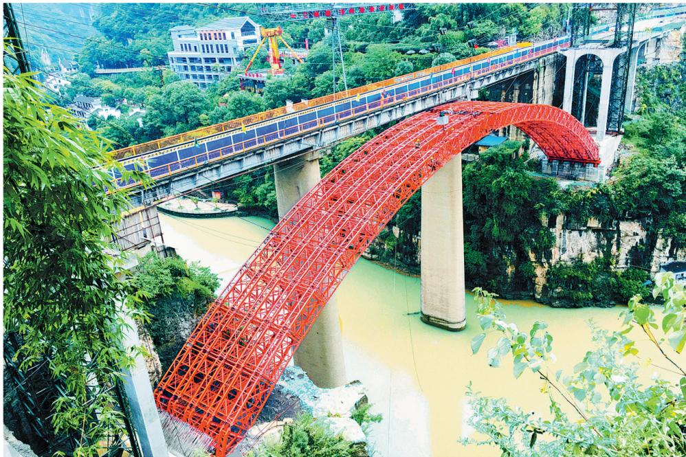
近日,由中铁二十局承建的湖北省宜昌市西陵峡口下牢溪大桥新建左幅桥轻型钢拱架合龙。该桥采用缆索吊悬拼轻型钢拱架进行施工,是宜昌市利用长江经济带旅游资源带动经济发展的一个缩影,建成后有效缩短宜昌城区通往国家5A级景区三峡人家,4A级景区三游洞、龙泉山庄的通行时间。图为作业人员正在进行大桥钢拱架吊装。 陈福得 摄
